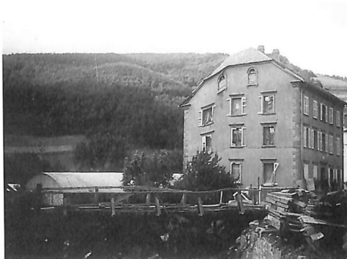
Pont sur la Weiss en partie détruit, décembre 1944
